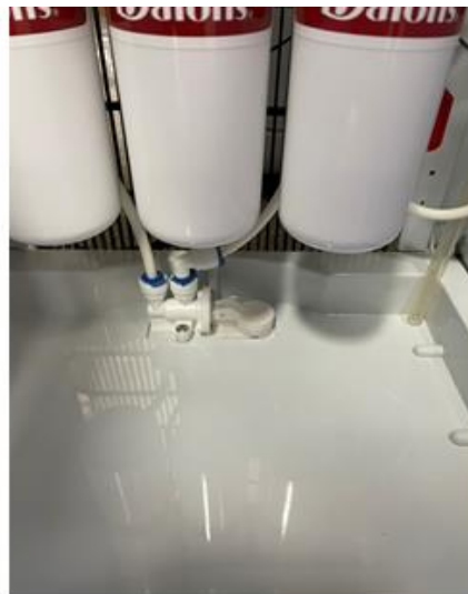
漏水遮断装置の蓋を閉める
